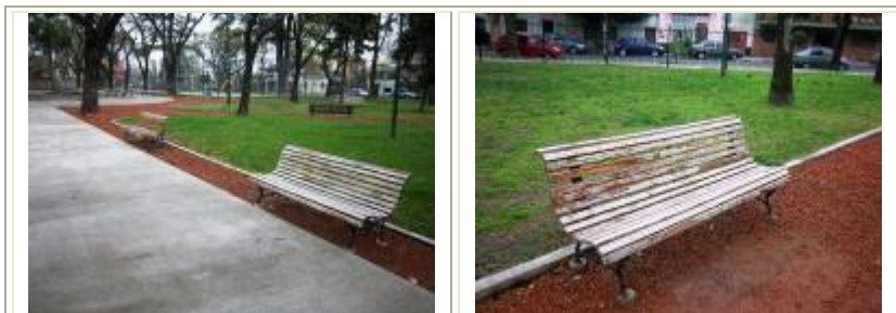
Foto N° 54 y 55. Falta de pintura –barniz- en los bancos.
