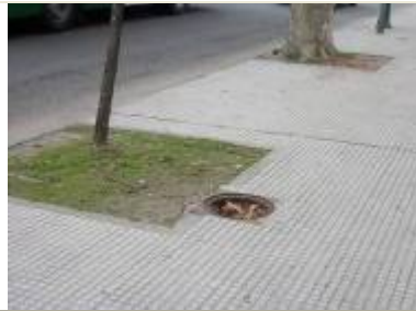
Foto N° 95 a 97. Falta de tapa de servicio sobre vereda, rejas subterráneas sobresalientes sobre sendero, acumulación de ramas sin el correspondiente embolse.
