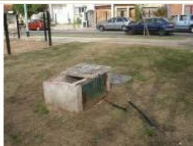
Foto N° 30 a 32. Cámaras sin tapas y caños expuestos, banco deteriorado sin posibilidad de uso y cartelera inutilizada por vandalismo fue rectificado a la fecha – agosto 2011-
