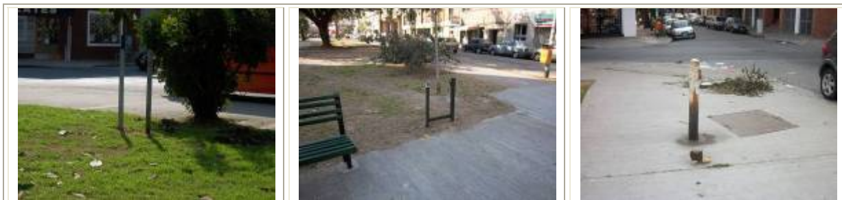
Foto N° 36 a 38. Falta de reposición de mobiliario.
