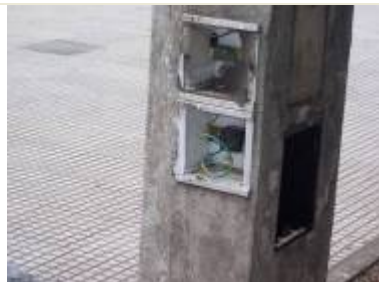
Foto N° 101 a 103. Tableros eléctricos sin puertas con cables y conexiones expuestas; bebedero destrozado, fuera de funcionamiento.
