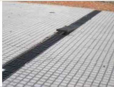
Foto N° 95 a 97. Falta de tapa de servicio sobre vereda, rejas subterráneas sobresalientes sobre sendero, acumulación de ramas sin el correspondiente embolse.
