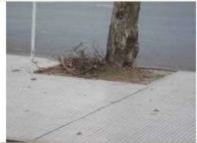
Foto N° 95 a 97. Falta de tapa de servicio sobre vereda, rejas subterráneas sobresalientes sobre sendero, acumulación de ramas sin el correspondiente embolse.
