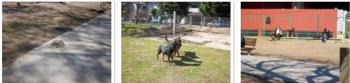
Foto N° 74 a 76. Falta de reposición de bebedero, sector de obra en construcción (cancha de mini-básquet) sin el vallado de protección adecuado. Falta construcción de canil.
